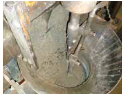
Fylling av betong.
