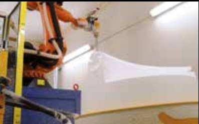
③ Godkjent kumutførelse sendes til en freserobot som lager støpeform. Ferdig kum blir identisk med tegningsgrunnlaget!
