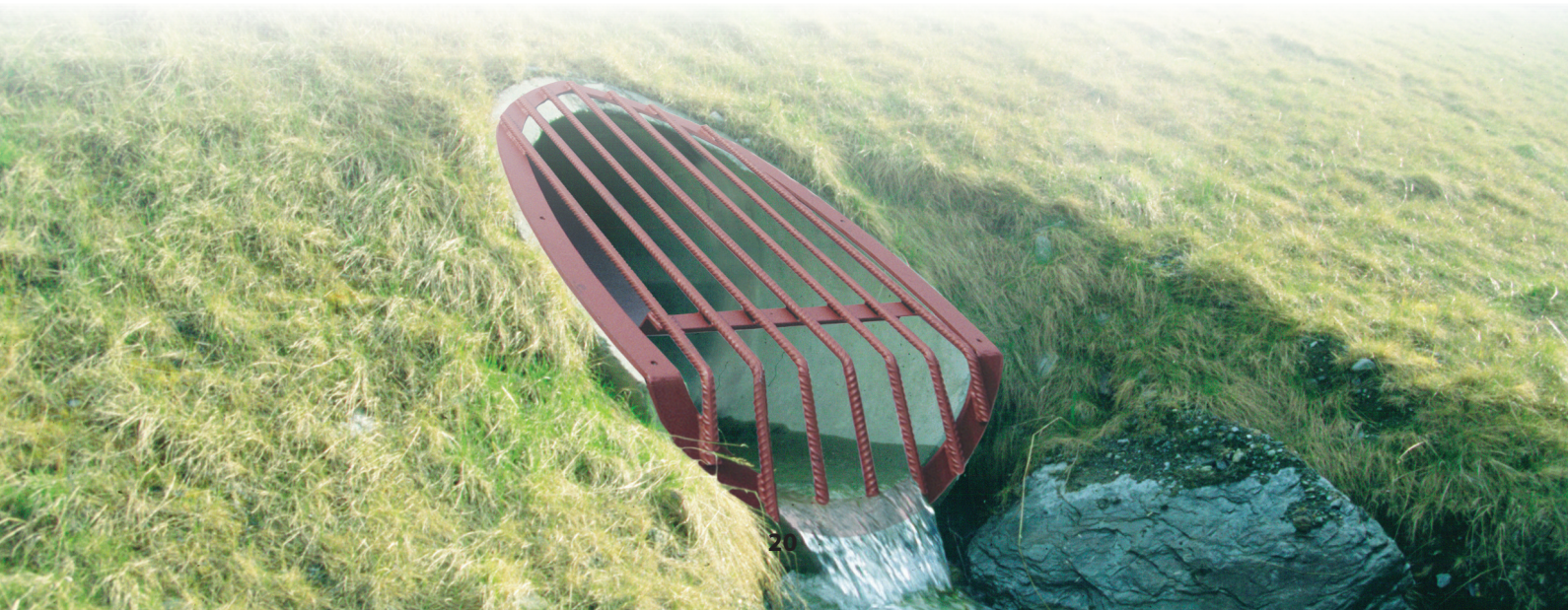
Illustrasjonen viser skrårør m/muffende.
