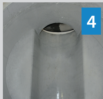
Ferdig støpt renneløpskum med briljant finish
